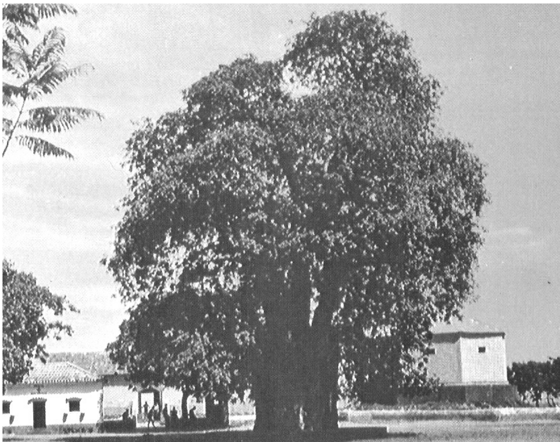
Forte Roçadas no Alto Encombe [7] . Os pavilhões amarelos datam da construção
